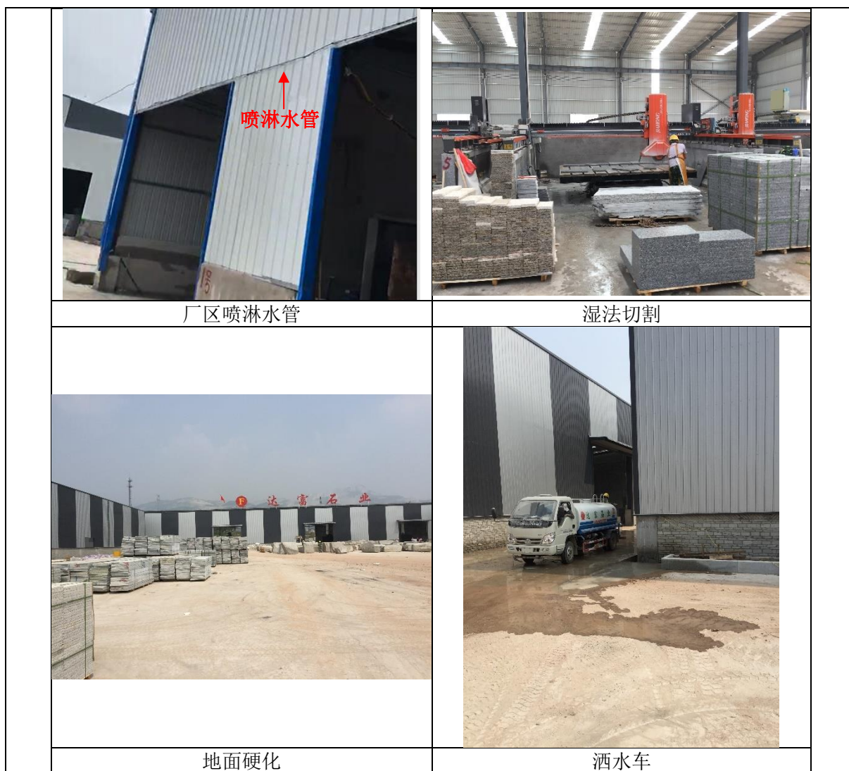
图 3-1 废气治理措施
