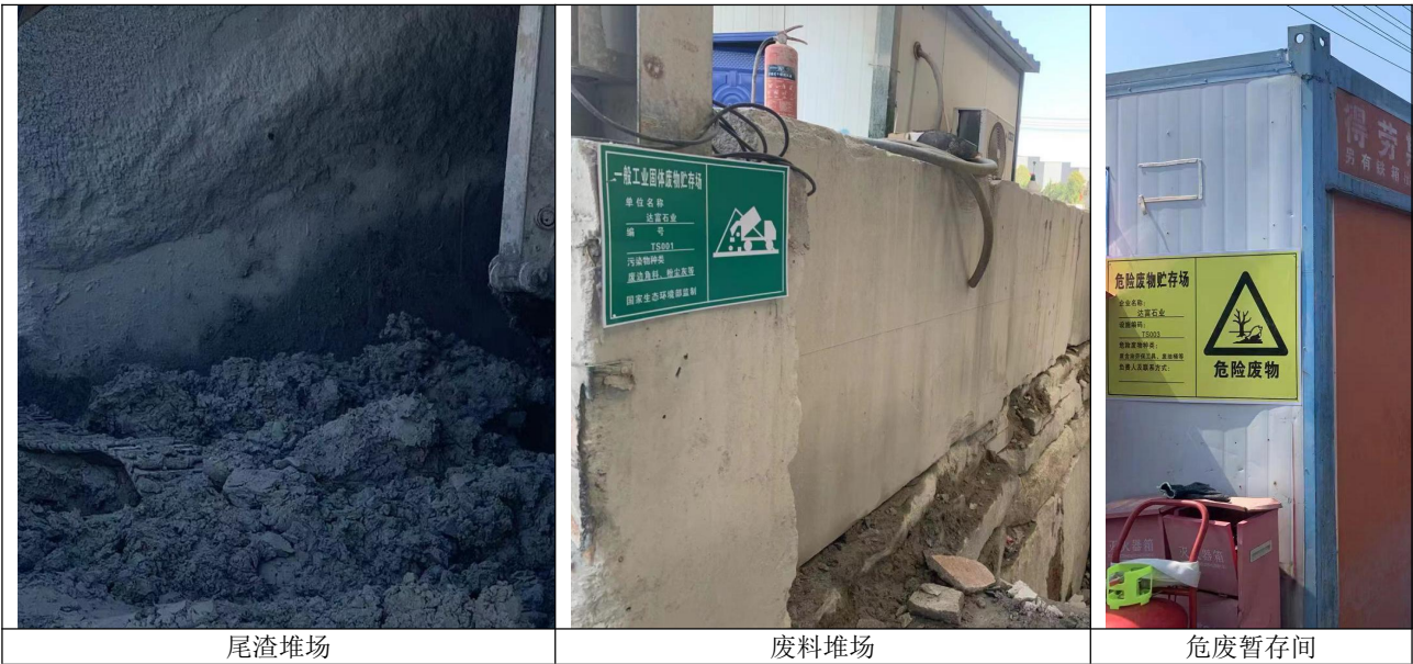
图 6 项目固废贮存设施现场照片
