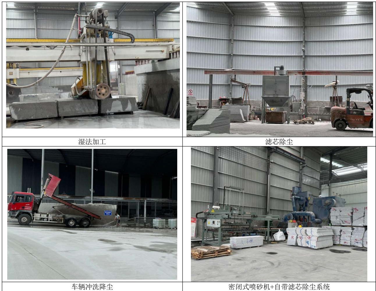
图 5 项目废气防治措施现场照片
