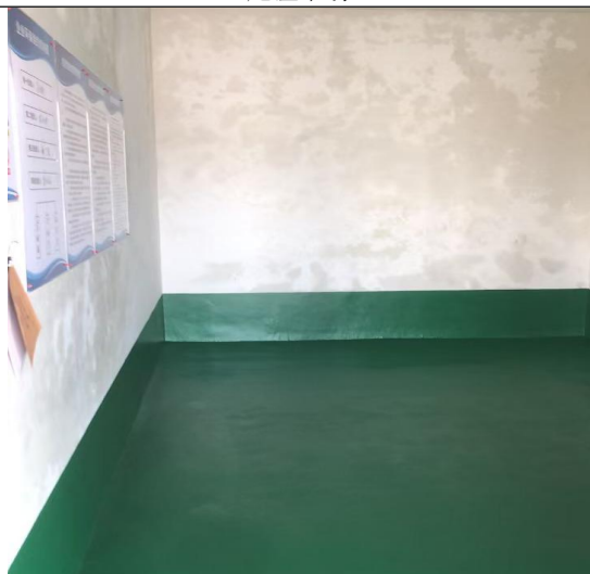
危险废物暂存间
