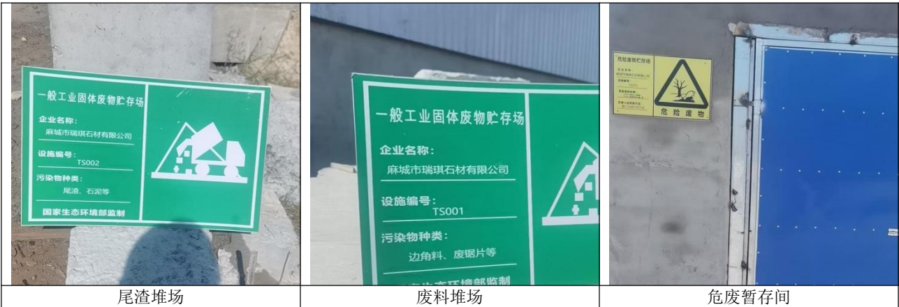
图 9 项目固废贮存设施现场照片
