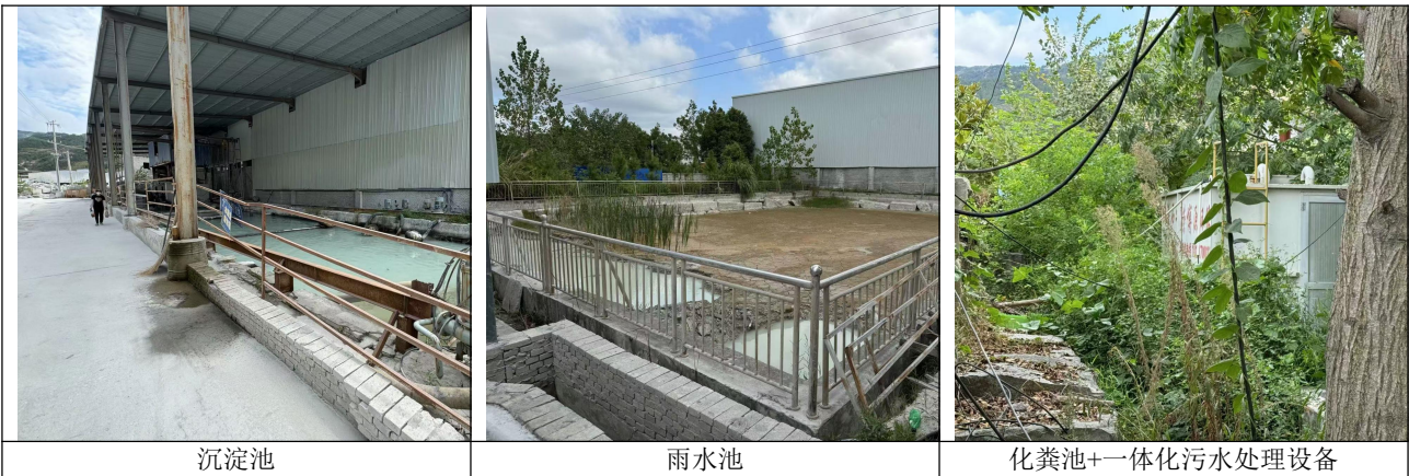
图 6 项目废水防治措施现场照片
