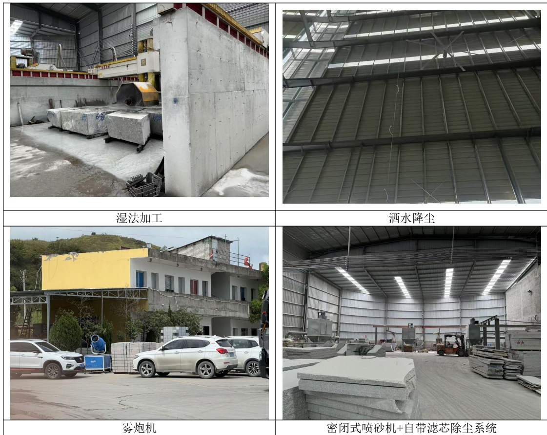
图 5 项目废气防治措施现场照片
