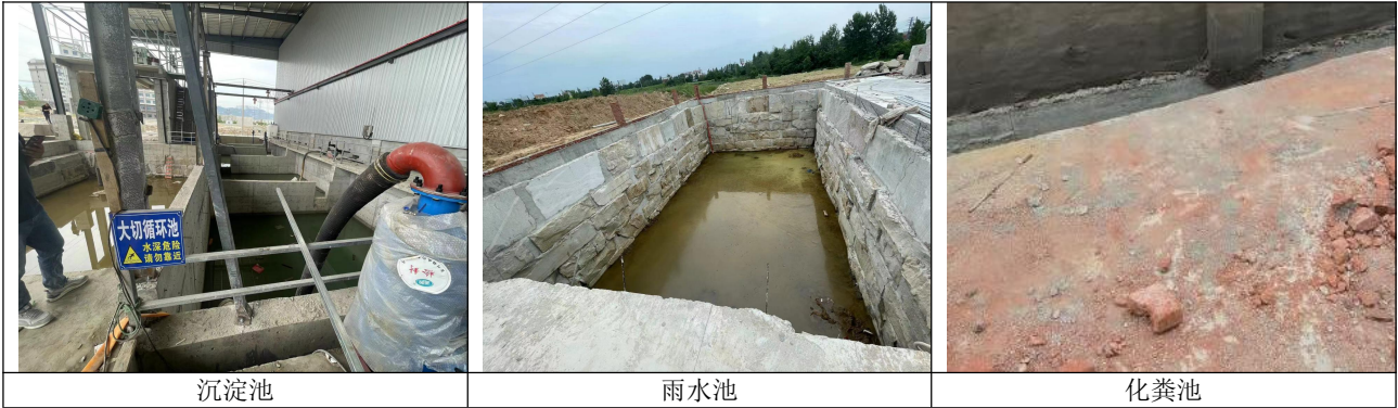
项目废水防治措施现场照片
