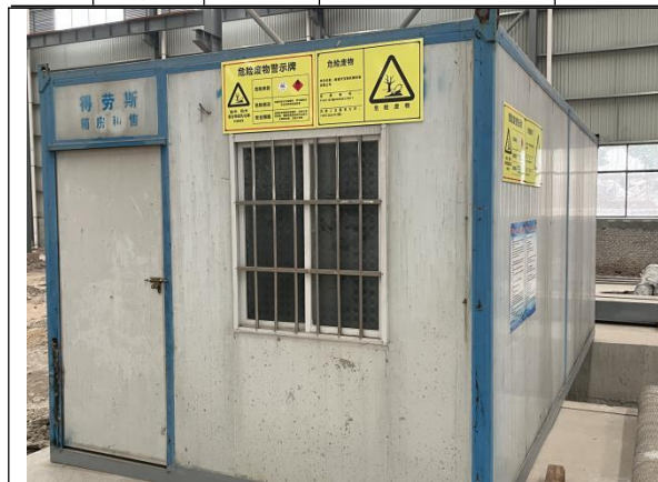
危废暂存间标识
