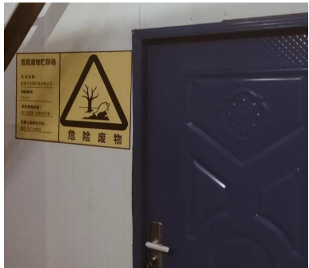
二次危废间外部大门及标识牌
