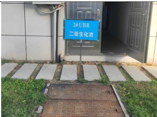
2# UBR 二级生化池
