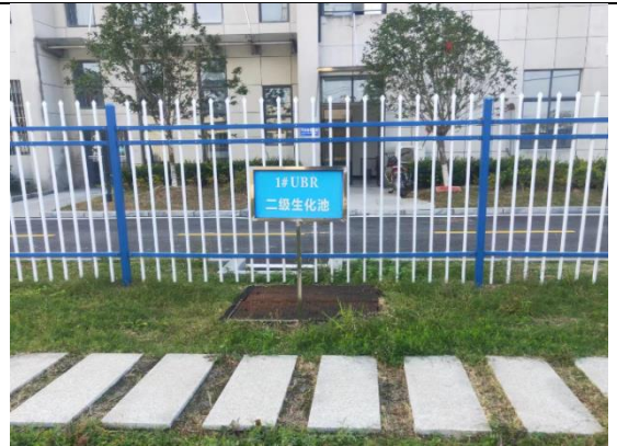
1# UBR 二级生化池
