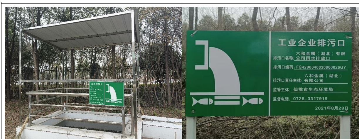
依托废水排放口标识牌（六合金属）
