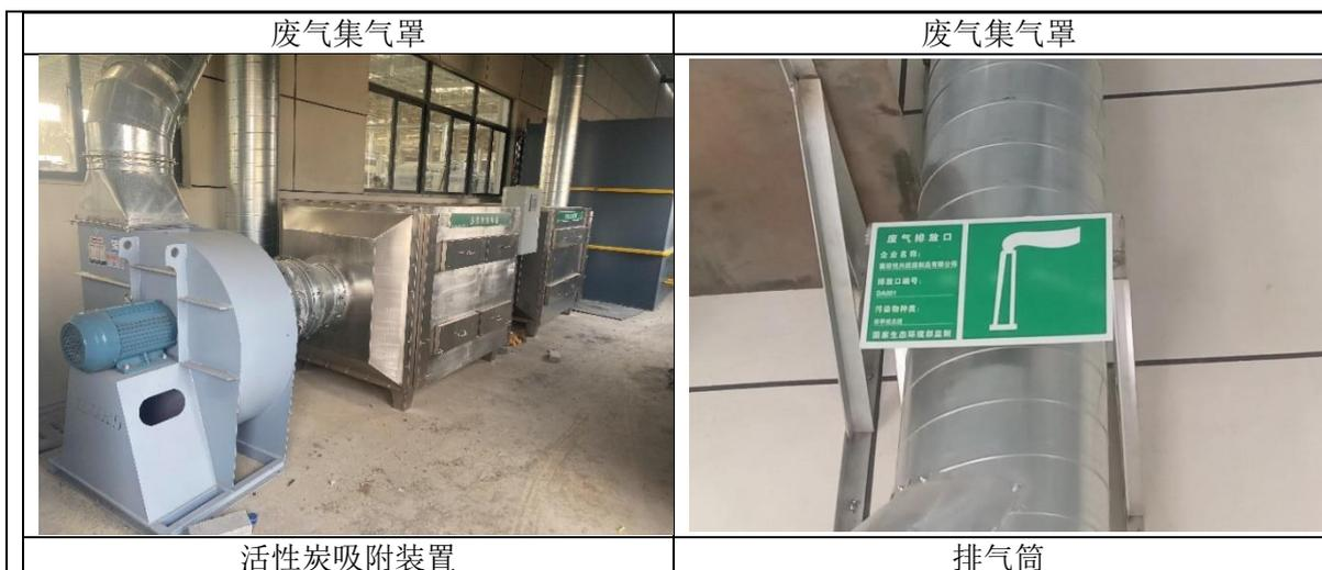
图 3-1 印刷废气防治措施
