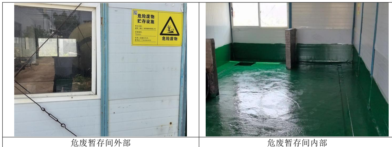
图 4 危废暂存间照片
