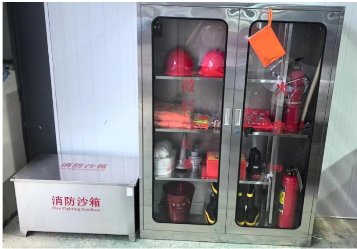
应急柜（安全帽、消防雨靴、应急灯、灭火器、沙土等）
