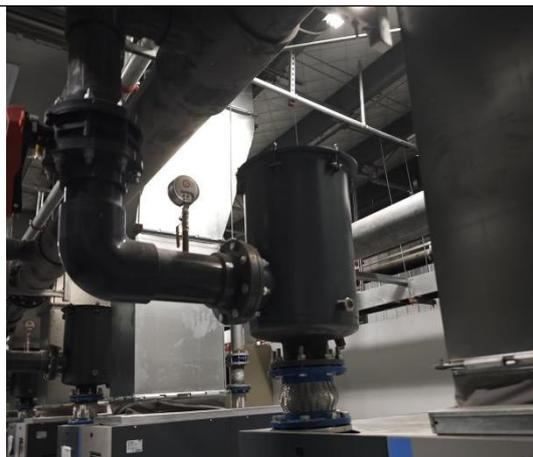
真空镀膜油泵“分离+过滤”处理装置
