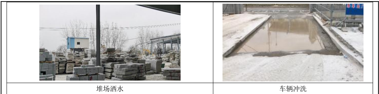
图 3 项目废气防治措施现场照片
