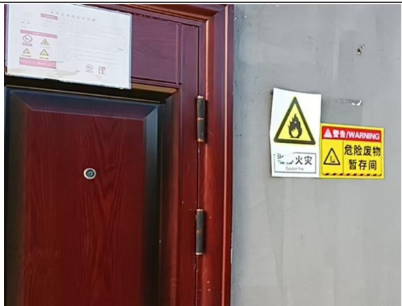
项目危险废物暂存间
