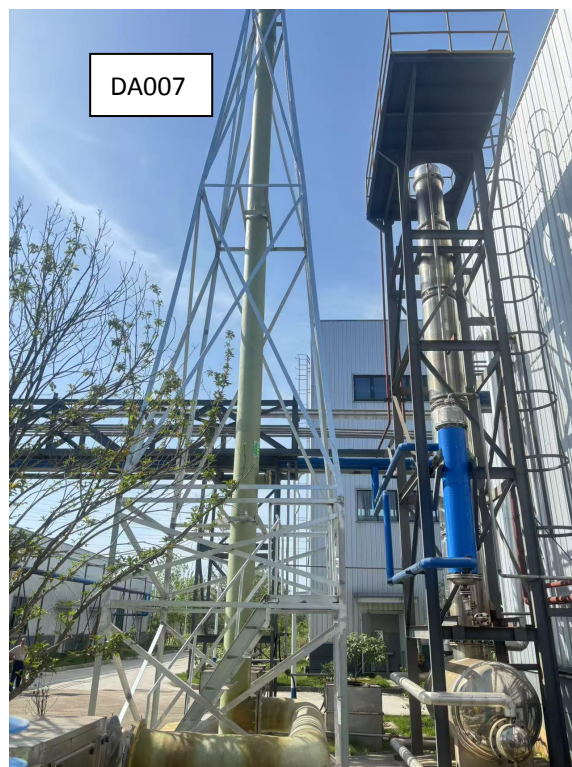
提取车间排气筒
