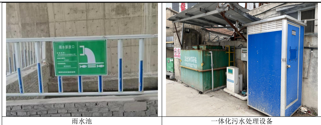
图 7 废水防治措施现场照片
