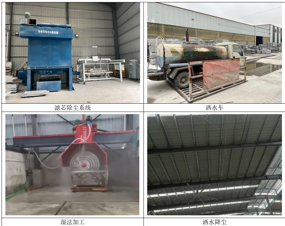
图 6 废气防治措施现场照片
