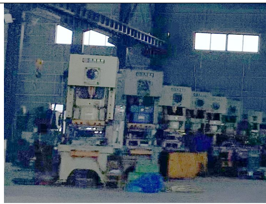
车间设备基础减震
