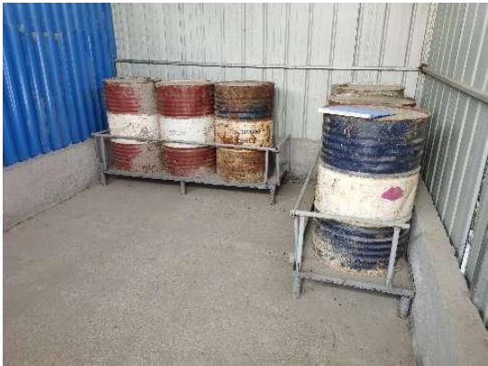
危废暂存间内部
