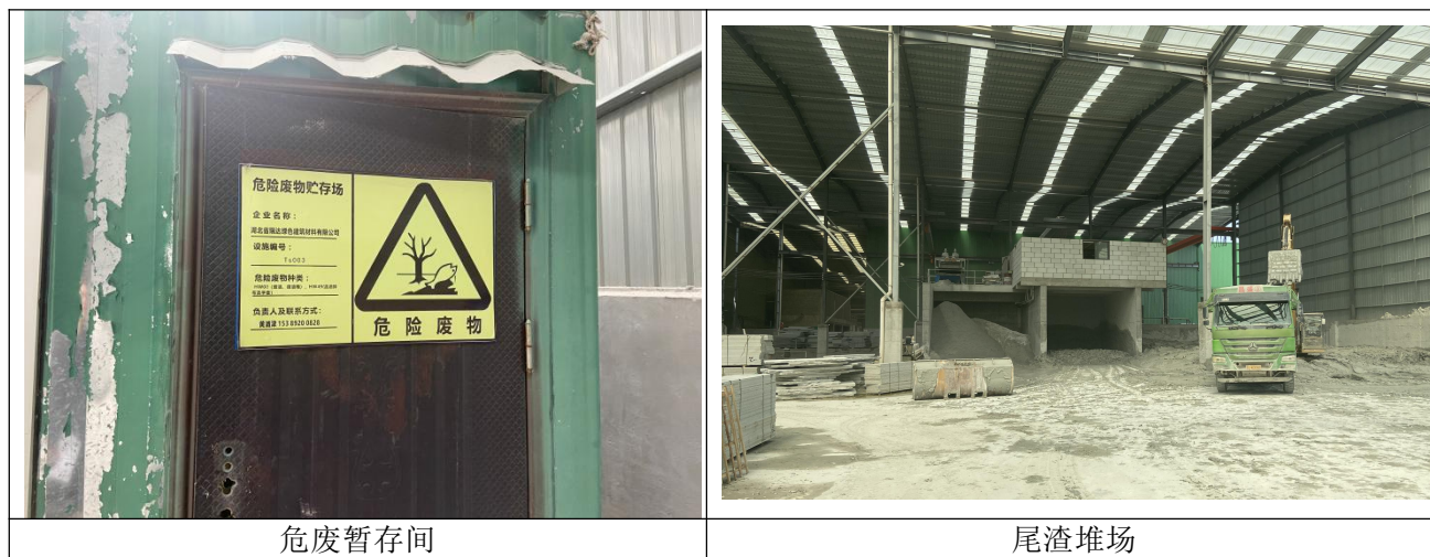
图 4 固体废物储存设施照片
