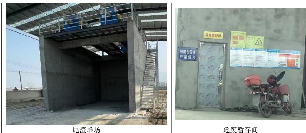
图 7 项目固废贮存设施现场照片
