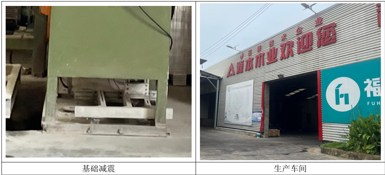
图 3 项目噪声防治措施现场照片
