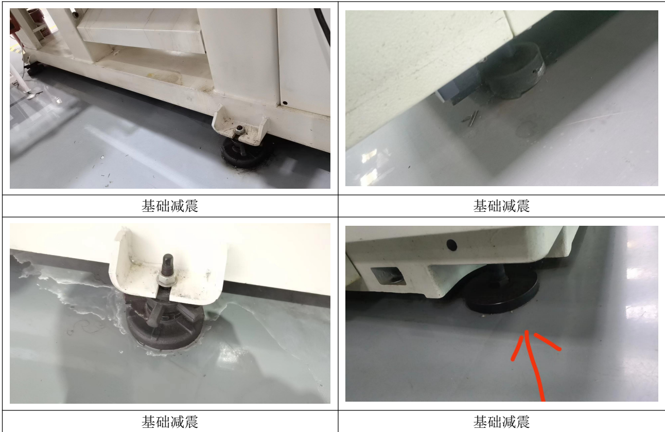
图 12 项目噪声防治措施现场照片
