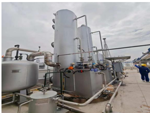
新 D-30 装置废气处理水喷淋及除雾干燥
