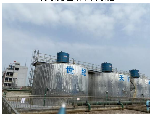
污水处理站 UASB 罐
