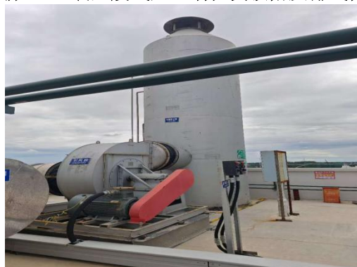
氯化铵装置废气处理水浴除尘器
