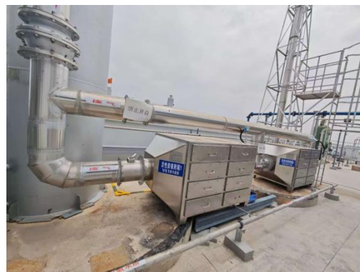
新 D-30 装置废气处理活性炭吸附及排气筒
