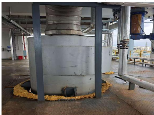
氯化铵装置废气处理旋风除尘设施
