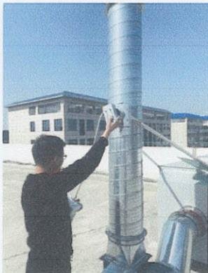
G6 清洗剂挥发废气排气
