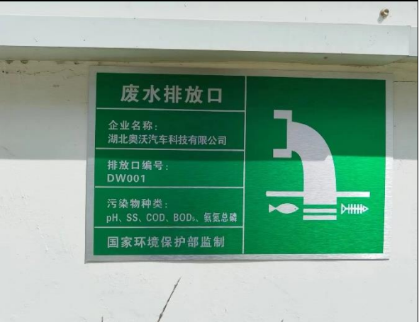
废水排放口标识牌
