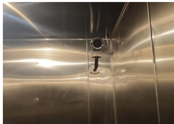
辐照车间内摄像头 2
