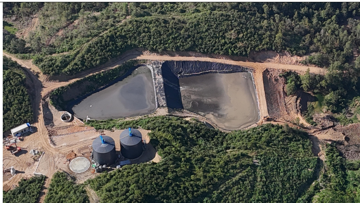
粪污处理工程（沼气工程）航拍图
