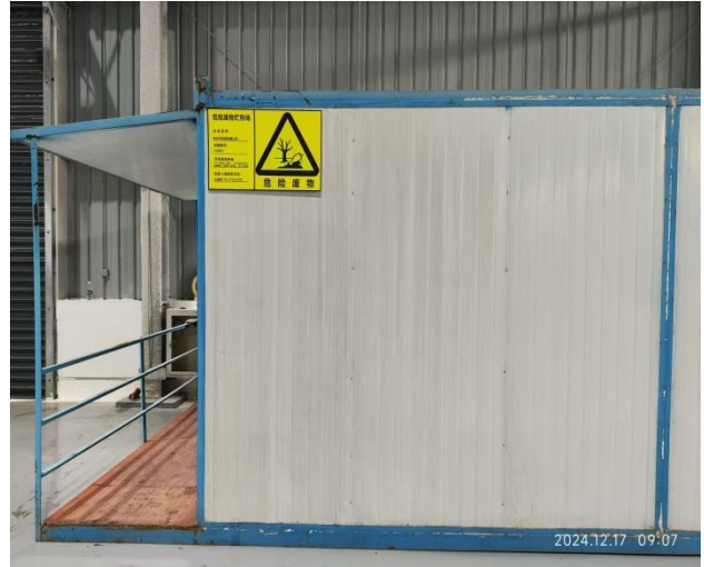
危废暂存间及标识牌
