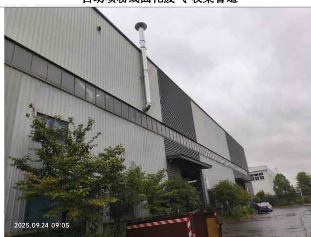
手动线喷粉线固化废气排气筒 DA002
