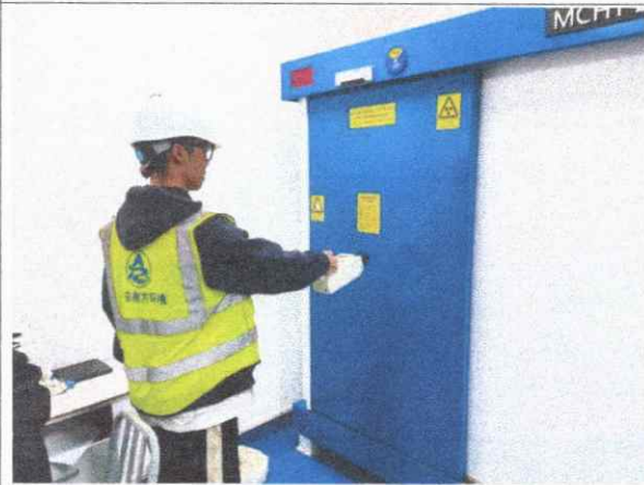
X-Ray 检测设备防护铅房防护门
