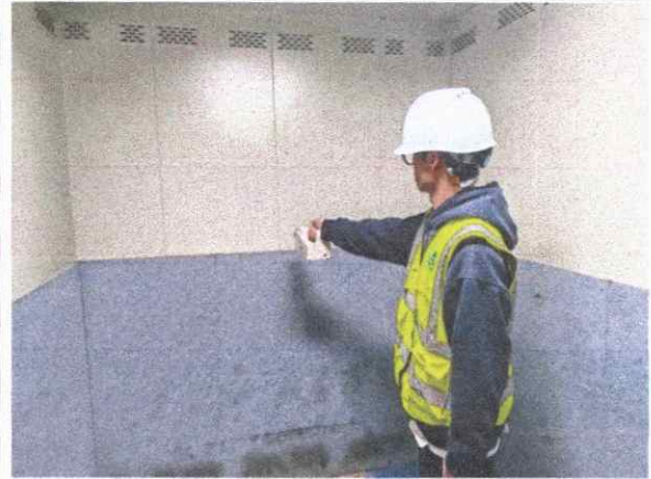
X 射线检测室西墙（电梯内）
