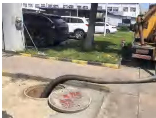
东环车身化粪池清淤操作
