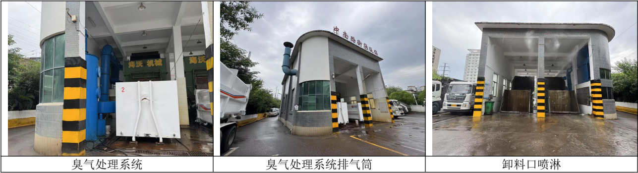
图 3 废气防治措施现场照片
