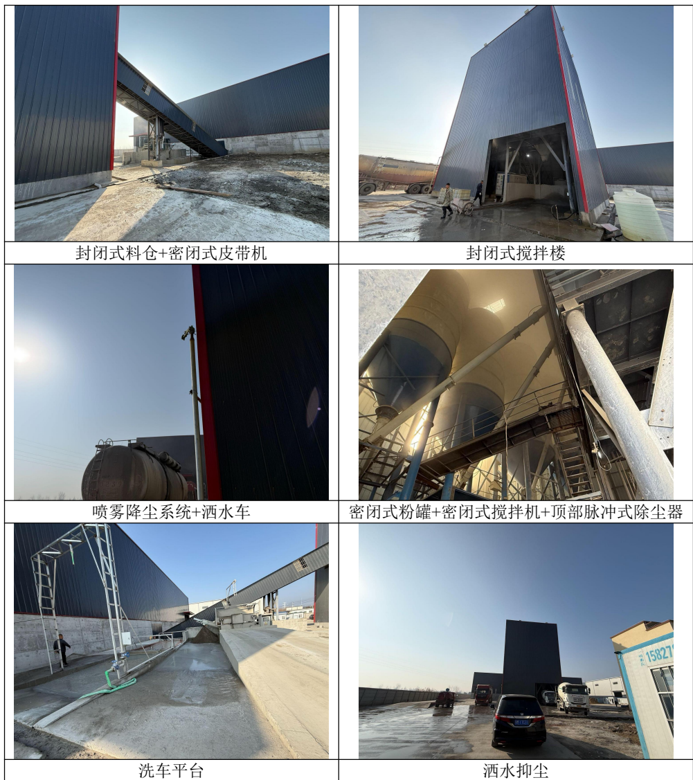
图3 废气防治措施现场照片
