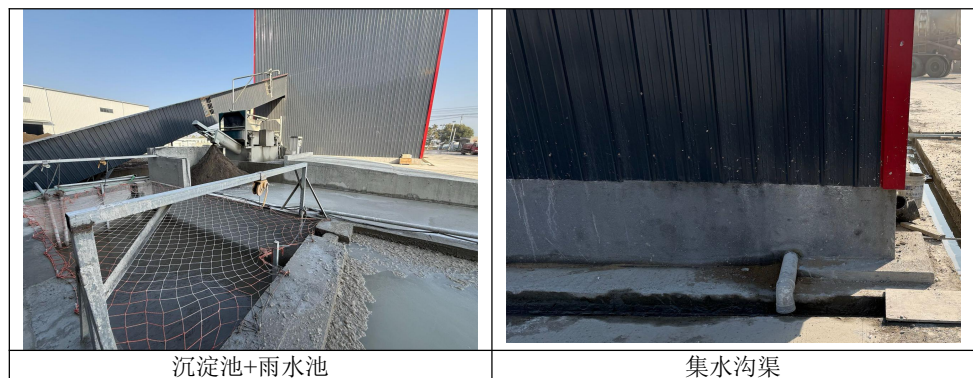
图4 废水防治措施现场照片
