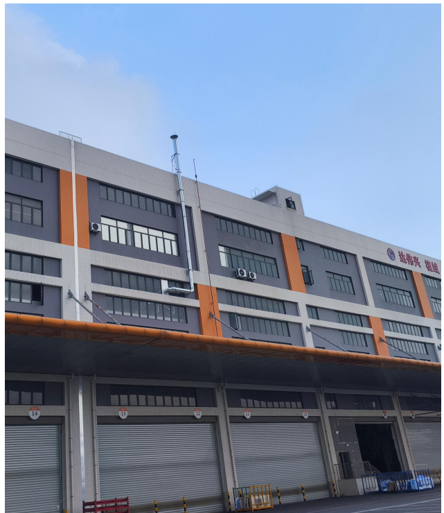
养护废气排气筒位置（DA002）
