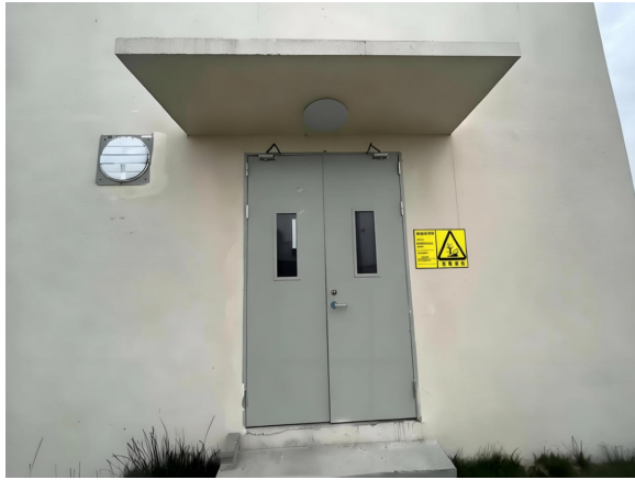
危废暂存间外部
