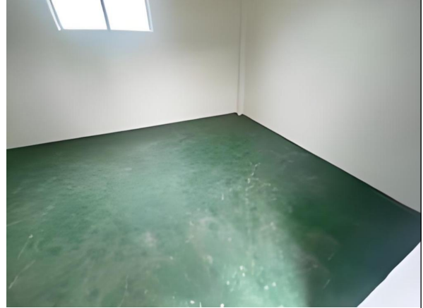
危废暂存间内部
