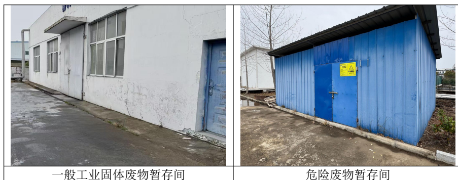
图 3 本项目固废贮存设施现场照片
